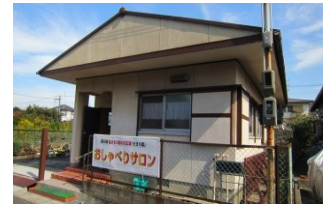
拠点づくり 空き家を改修に地域活動に活用
