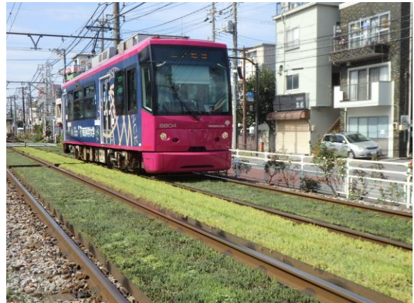
第18回 環境大臣賞 壁面・特殊緑化部門:都電荒川線無灌水型軌道緑化(荒川車庫前停留場付近)
